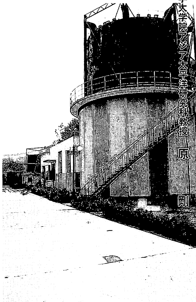
アメリカから導入した家畜の排せつ物によるメタンガス発電装置
