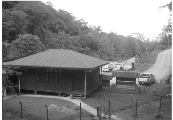
サバ州マファサブステーション
